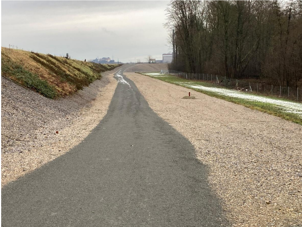
Bild 17: Foto von Berme mit wassergebundener Deckschicht (dunkelgrau) und rd. 5 m breiter Schotterbefestigung unter geplanter BE-Fläche (rechts neben Weg)
